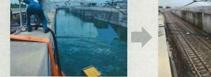
台風18号により関西国際空港が浸水。連絡している南海電鉄の線路も水没しました。排水するためには、揚程と排水距離の問題から、電動式ポンプでは対応できず、ハイドロサブが動出し、復旧に貢献しました。
