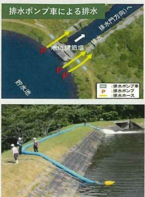
全国に15万カ所あるため池のうち約1/3が決壊リスクを抱えているとされています。年々雨量の増加によりため池の水位上昇が更なるリスクを高めています。昨年4月には農林水産省がため池決壊対策及び干ばつ被害対策としてハイドロサブHS60を7台導入し、全国に配備いたしました。
