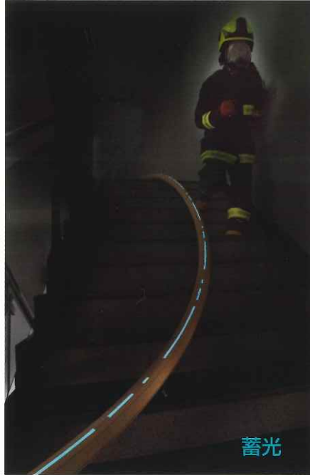
蓄光または光りを当てるとシルバーに反射するので暗闇でも、それを辿れば退路方向が分かります。
