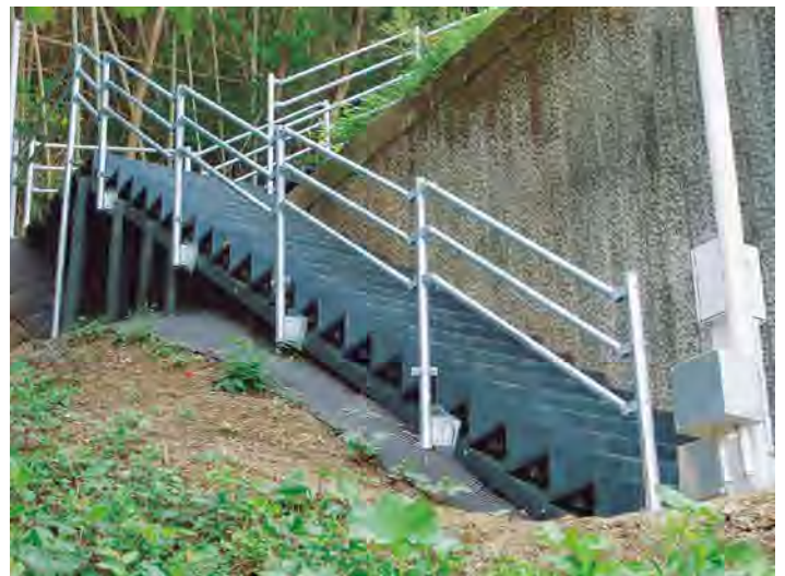
国土交通省 中村河川国道事務所発注 平成23-24年度 白浜歩道外工事(佐賀地区 横浜トンネル)
