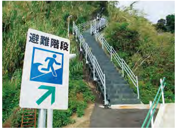
国土交通省 中村河川国道事務所発注 平成23-24年度 白浜海岸防災対策工事(白浜地区)
